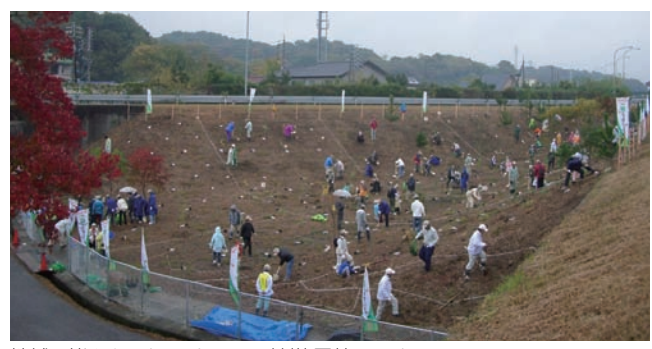
地域の皆さまによるのり面への植樹 岡崎 IC のり面
