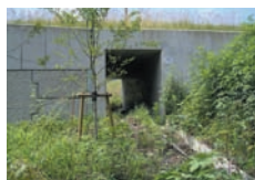
高速道路下に設けた通路（ボックス）
