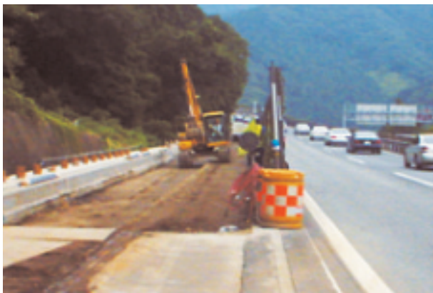
小仏トンネル付近の付加車線設置工事
