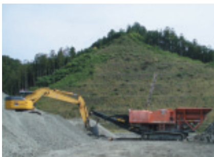
建設現場での現場発生石の破砕
