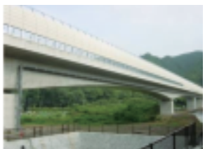
遮音壁の景観
