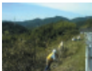
高速道路のり面の草刈など
