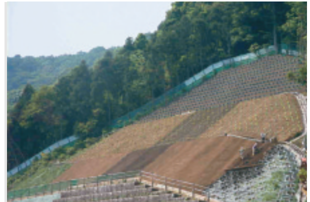
圏央道八王子JCT 植栽直後(2000.5)
