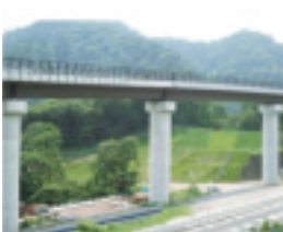
周辺色彩に配慮した柵
