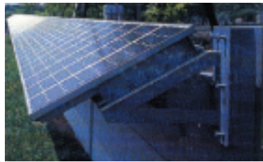
東名足柄SA太陽光発電システム （身障者用駐車場部） 年間発電量約0.25万kwh CO 2 削減量約835kg （遮音壁部） 年間発電量約0.5万kwh 【SA年間使用電力の約0.1%】 CO 2 削減量約1.7t
