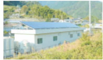
中央道談合坂SA（上り）太陽光発電システム 年間発電量約1.5万kwh 【SA（上り）年間使用電力の約0.5%】 CO 2 削減量約5t
