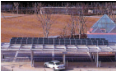
東名足柄SA太陽光発電システム （身障者用駐車場部） 年間発電量約0.25万kwh CO 2 削減量約835kg （遮音壁部） 年間発電量約0.5万kwh 【SA年間使用電力の約0.1%】 CO 2 削減量約1.7t
