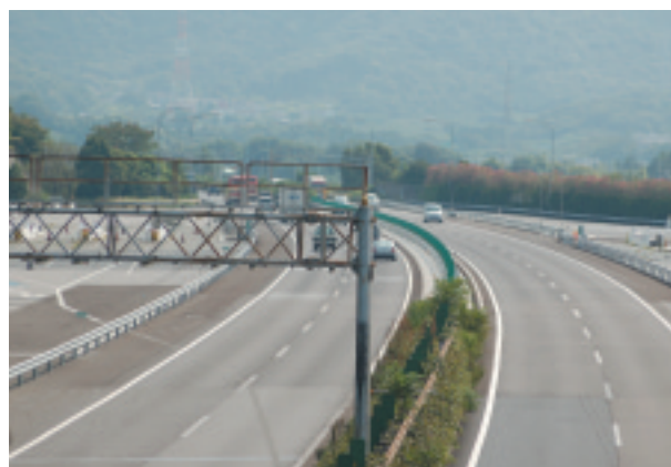
東名 豊橋本線料金所（廃止後）
