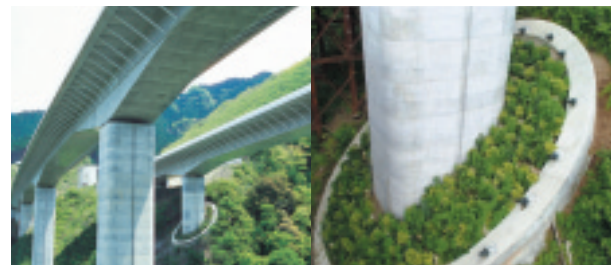
新東名 芝川高架橋
