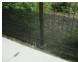
小動物侵入防止対策
