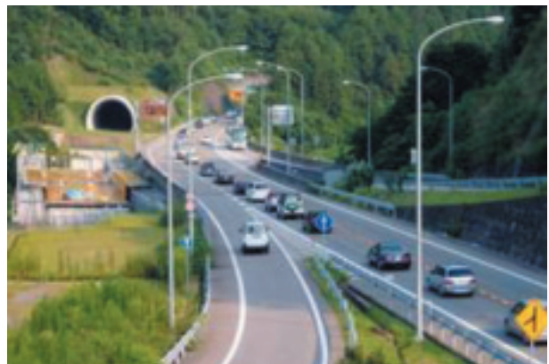
苅安トンネル付近を 先頭とした渋滞が発生
