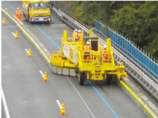
【E1 東名高速道路における移動式防護柵の設置状況】
