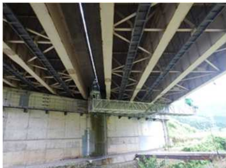
【従来の橋梁点検「橋梁点検車を活用」】
