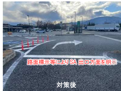
【E20中央道 双葉 SA 下りにおける対策状況(路面標示(矢印)、ラバーポールの施工)】
