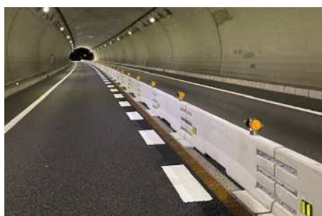
【左:センターブロック(C3東海環状道 枋洞トンネル)】
