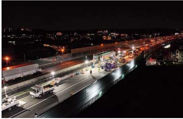
【E1東名高速道路 東名多摩川橋】 （現況の車線数を確保した床版取替え）
