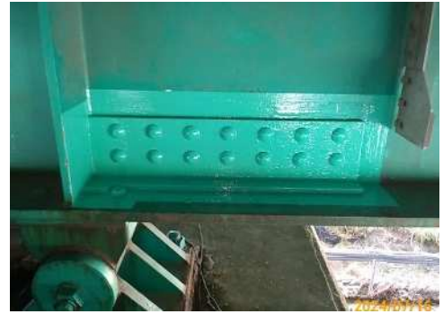
【速やかな対策が必要な変状の措置事例 鋼桁端部の断面欠損(E23 東名阪自動車道)】
