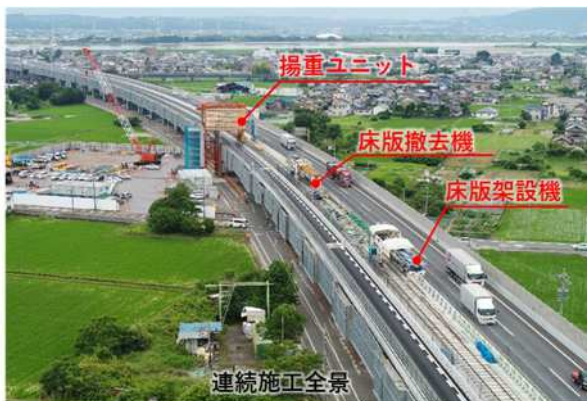
【E23東名阪リニューアル工事 弥富高架橋における高架下の沿道からの資機材搬入出や運搬用の軌道設備】
