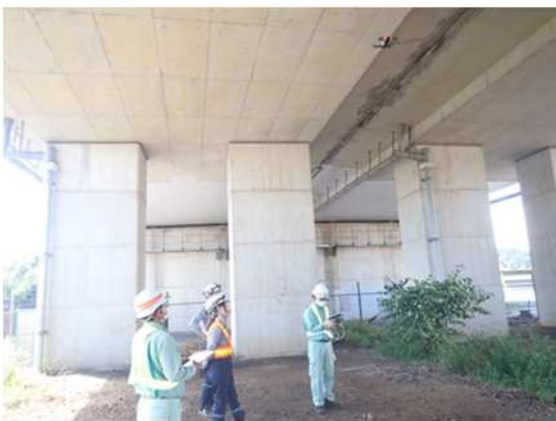
【無人航空機(UAV)を用いた橋梁の点検実施状況】
