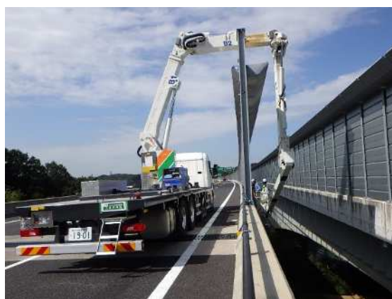
【遮音壁の点検実施状況】
