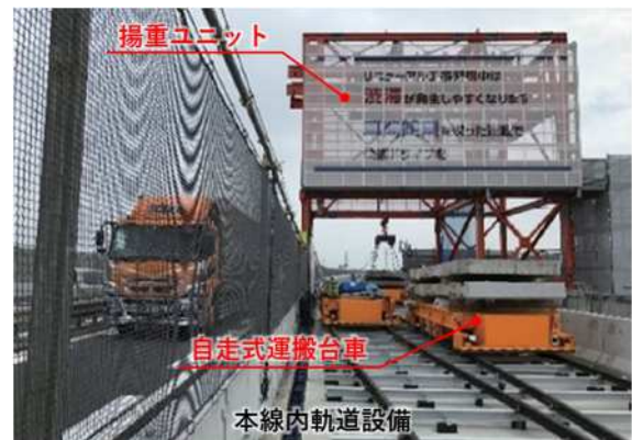
【E23東名阪リニューアル工事 弥富高架橋における高架下の沿道からの資機材搬入出や運搬用の軌道設備】
