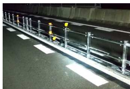
【左:センターブロック(C3東海環状道 枋洞トンネル)】
