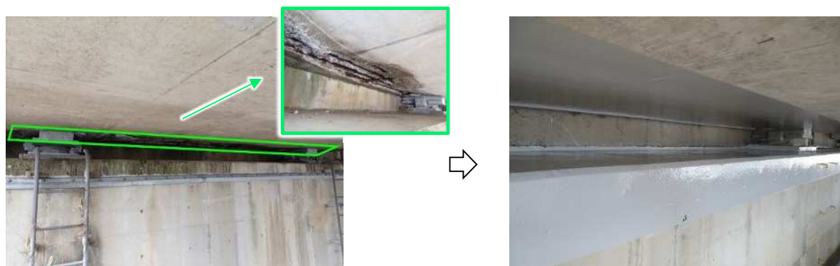
【判定区分Ⅲとした施設の修繕事例 橋梁上部工等の損傷(E20 中央自動車道 竜王高架橋)】
