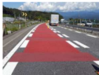
【事故対策事例(速度抑制対策:カラー薄層舗装)】
