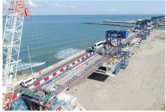
【E8北陸自動車道 手取川橋】 （対面通行規制による床版架替え）
