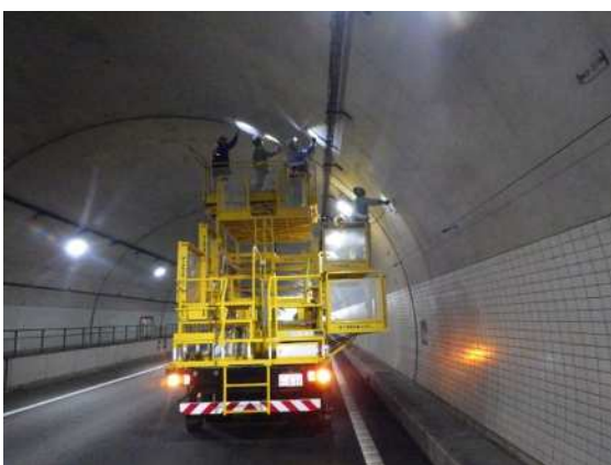
【トンネルの点検実施状況】
