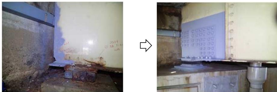
【速やかな対策が必要な変状の措置事例 鋼桁端部の断面欠損(E1名神高速道路)】
