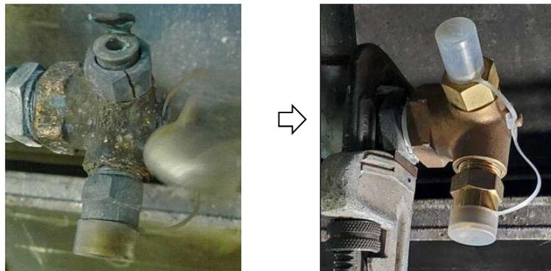
【速やかな対策が必要な変状の措置事例 水噴霧ヘッドの腐食劣化
