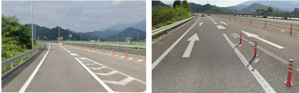
【逆走事案に応じた追加対策事例(合流部への矢印路面標示・ラバーポールの設置)】
