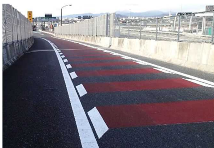
【事故対策事例(速度抑制対策:カラー薄層舗装)】
