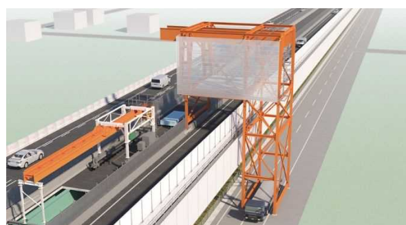
【資機材の搬入・搬出方法の工夫】
