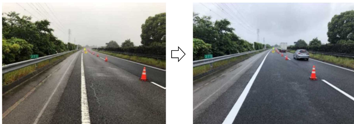
【舗装補修事例(E1東名高速道路 音羽蒲郡IC～豊川IC)】
