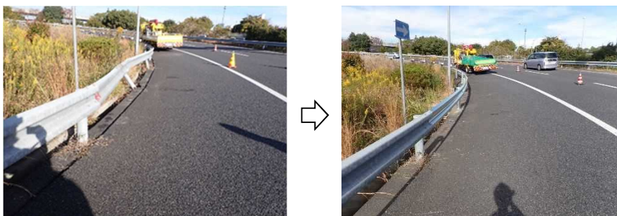
【交通事故復旧作業状況】
