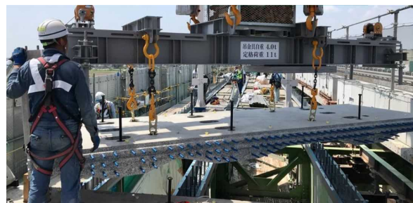
【新設床版設置状況】
