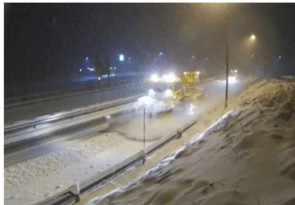
【予防的通行止め後の集中除雪の状況】
