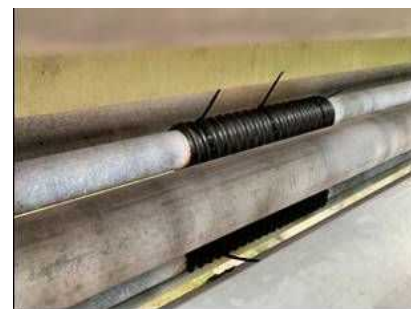
【速やかな対策が必要な変状の措置事例 電気・通信ケーブル用配管の腐食(E41 東海北陸自動車道)】
