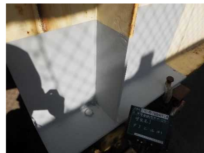
【速やかな対策が必要な変状の措置事例 橋梁主桁の腐食劣化(E8 北陸自動車道 足羽川橋)】
