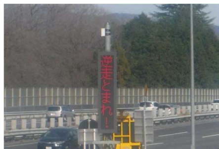
【3Dステレオカメラを活用した画像解析技術による逆走検知(談合坂SA(下り))】
