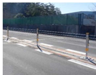
【中小橋区間(C3 東海環状道 関テクハイ橋)】
