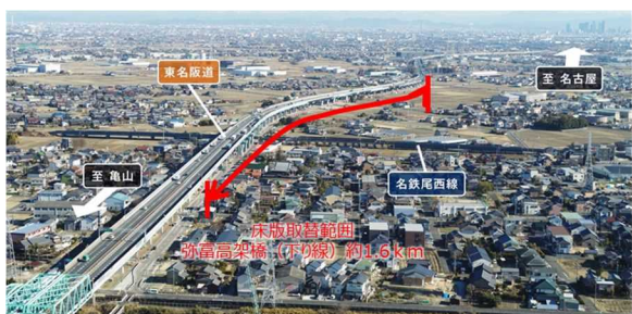
【E23 東名阪自動車道 弥富高架橋】
