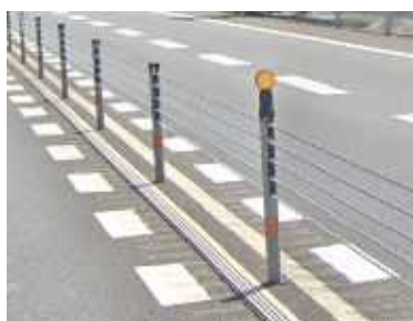
【土工区間(E52 中部横断道)】
