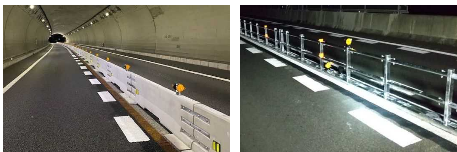
【左:センターブロック(C3 東海環状道 枋洞トンネル)】 【右:センターパイプ(E52 中部横断道 福士川第三橋)】
