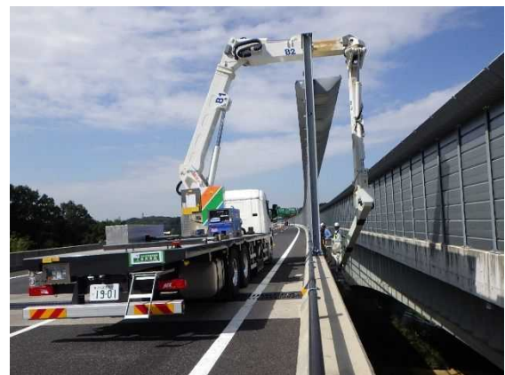
【遮音壁の点検実施状況】
