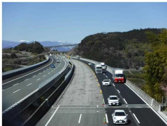
【EA1 新東名高速道路における車線運用状況】
