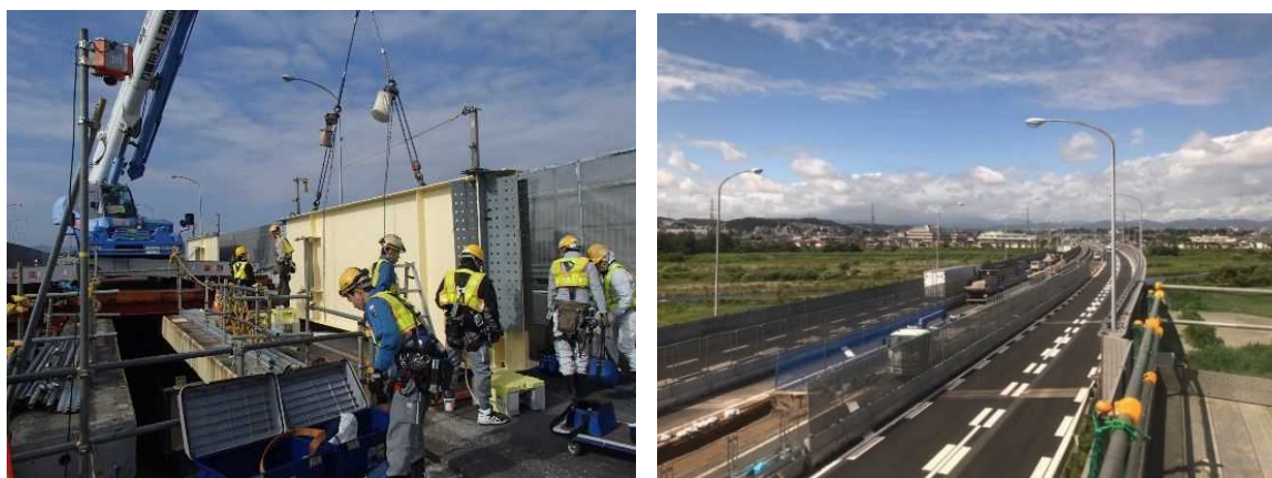
【E20 中央自動車道多摩川橋での床版取替工事】
