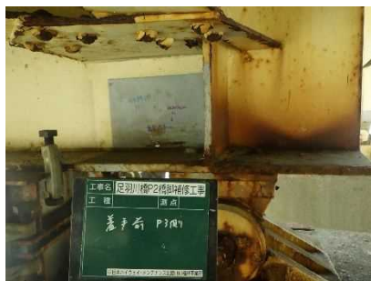
【速やかな対策が必要な変状の措置事例 橋梁主桁の腐食劣化(E8 北陸自動車道 足羽川橋)】
