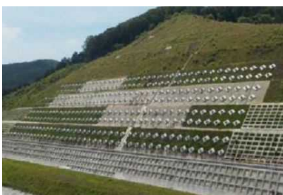
【グラウンドアンカーの状況】
