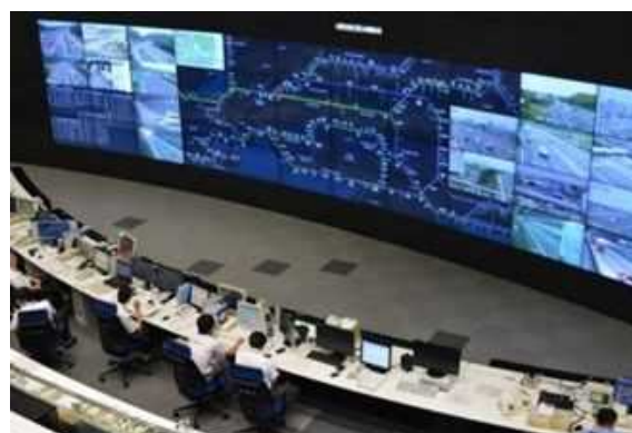
【道路管制センター】
