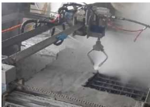
【コンクリートはつり状況】
