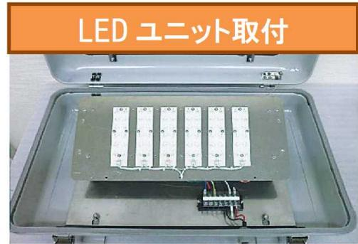
【既設トンネル照明灯具筐体を再利用した LED 化ユニット】
