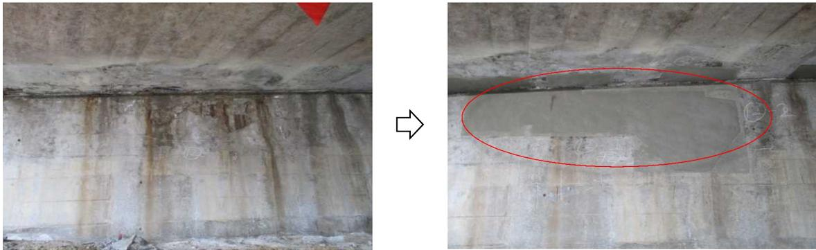
【診断結果Ⅲとされた施設の修繕事例(橋台コンクリートの補修)】
