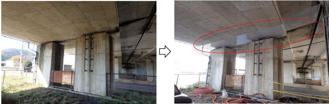
【診断結果Ⅲとされた構造物の修繕事例(橋梁床版コンクリートの補修)】
