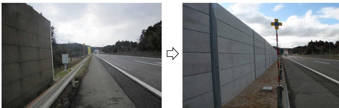
【遮音壁設置事例(名神高速道路 関ヶ原IC～米原IC間)】
