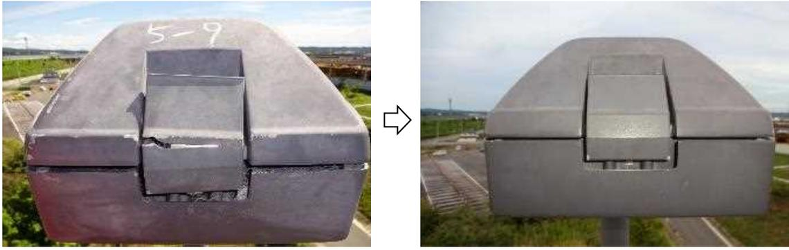
【速やかな対策が必要な変状の措置事例(道路照明灯具の腐食)】
