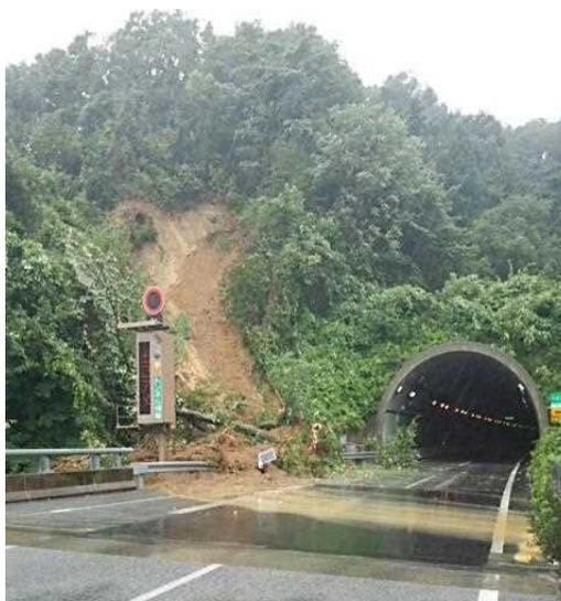
【切土のり面の崩落状況】
