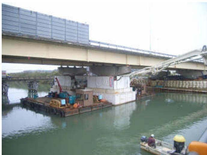
【北陸自動車道 大聖寺川橋における橋脚補強の施工状況】
