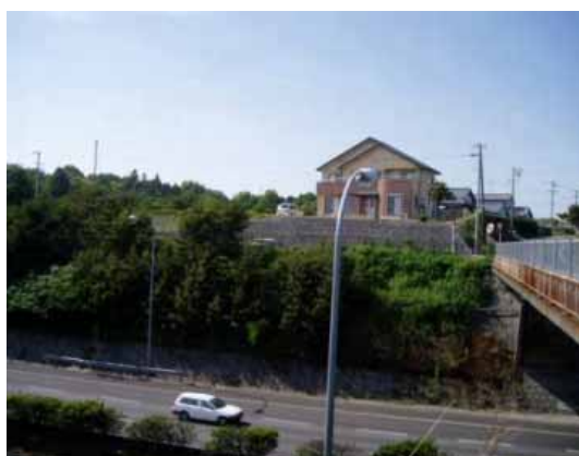
《遮音壁(施工前)》
