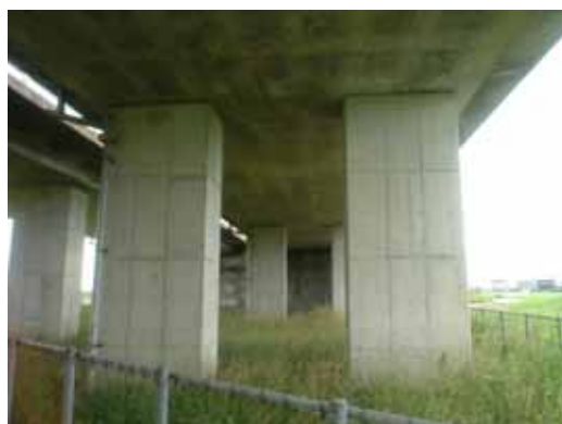
《橋梁補強（施工前）》
