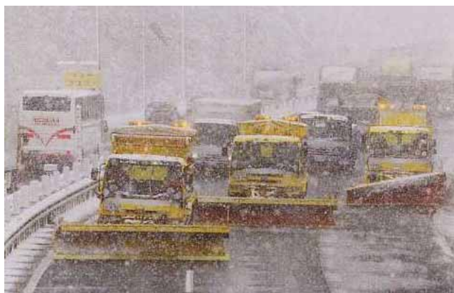
《除雪作業状況》
