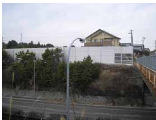
《遮音壁(施工後)》
