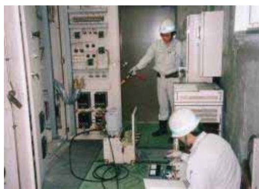
《施設設備点検》
