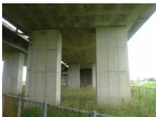
《橋梁補強(施工前)》
