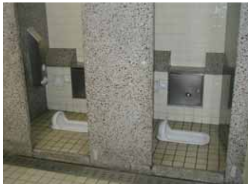
《お手洗い内段差解消前》
