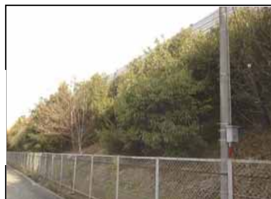
《樹林化(施工後)》
