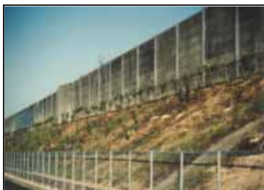
《樹林化(施工前)》
