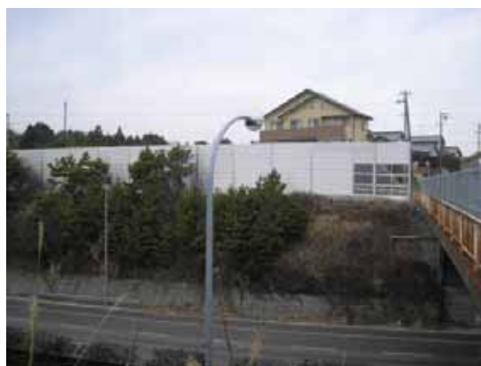
《遮音壁(施工後)》
