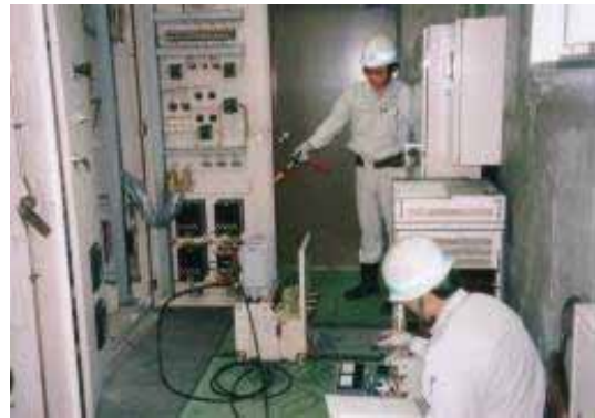
《施設設備点検》
