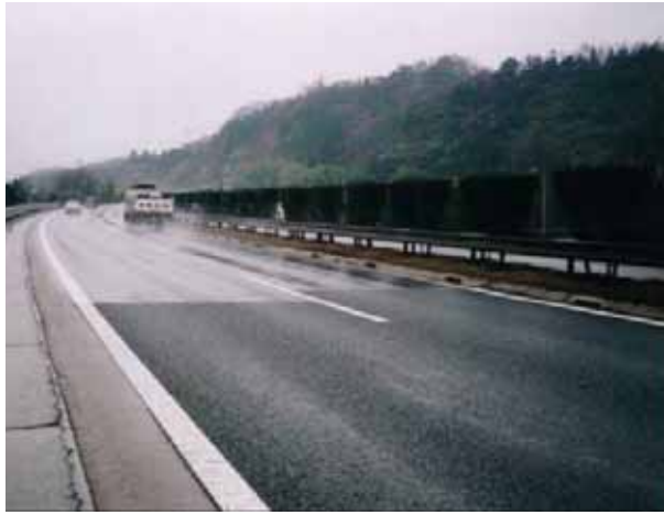
写真．高機能舗装の施工事例
