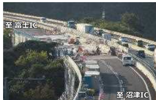
【柳沢第二橋 （東名（沼津IC～富士IC） 床版取替・対面通行の様子 〔2023.9～2023.12〕）】
