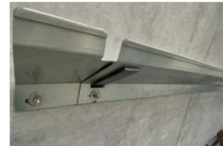
鋼板型のケーブルラック(改良)
