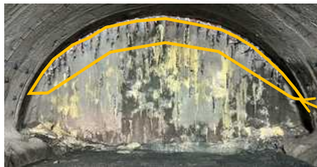
注入式長尺先受工（AGF）イメージ
