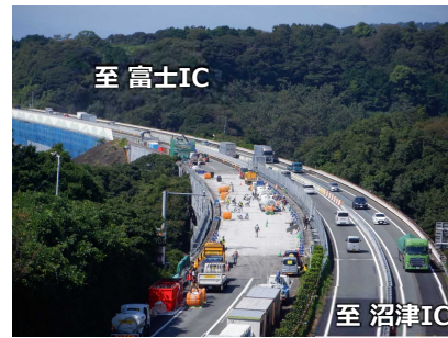
【柳沢第一橋 （東名（沼津IC～富士IC） 床版取替・対面通行の様子 〔2022.9～2022.12）】
