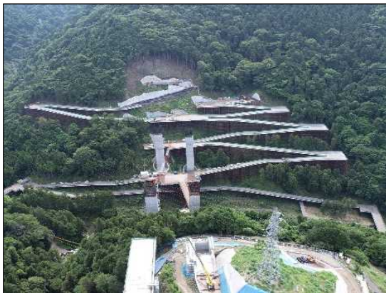
TN坑口への工事用道路
