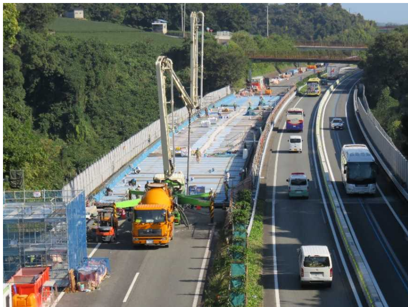
【東名荒久橋(東名(沼津～富士)床版取替・対面通行の様子[2019.9～2019.12])]】
