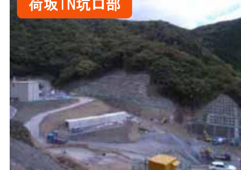
荷坂TN坑口部
