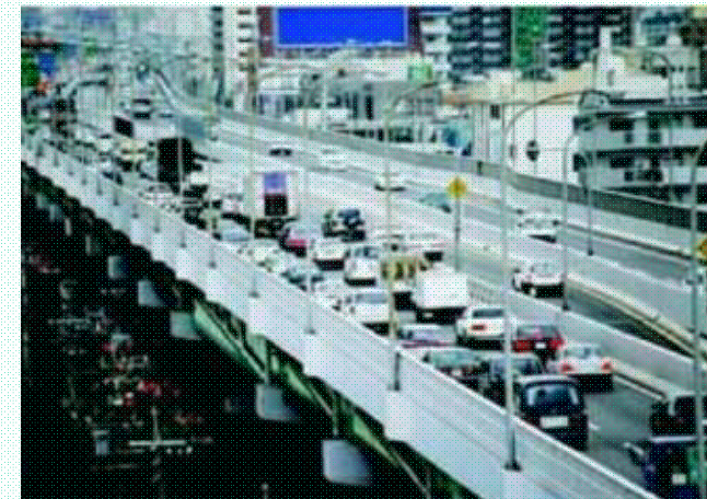
大高線上下り堀田入口付近
