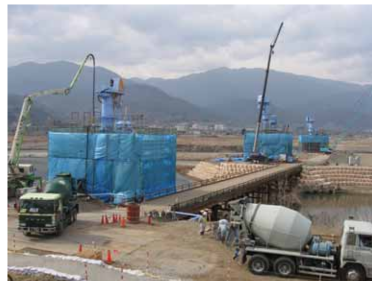
河川内施工状況(増穂町)
