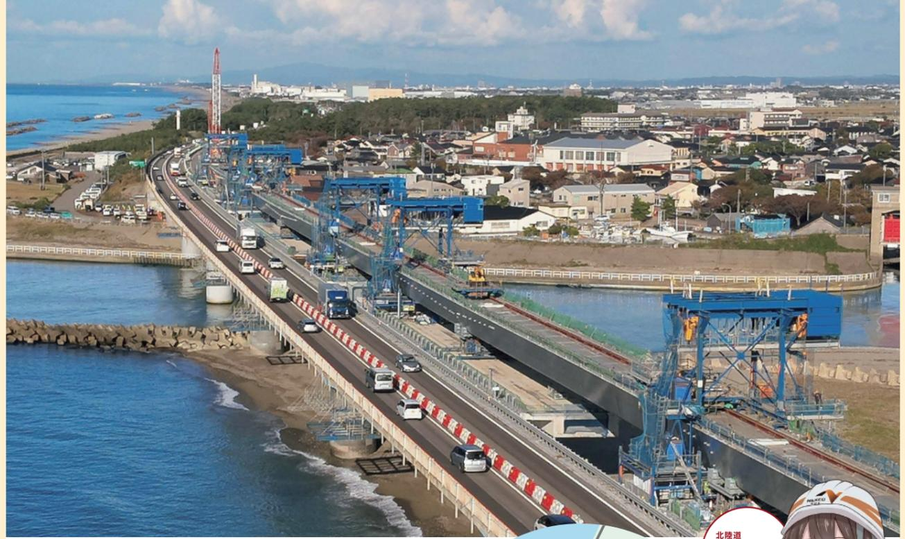
手取川橋は1972年の開通から50年が経過しました。日本海から近いため、飛来塩分に起因する塩害などの影響を受けて老朽化が進行しています。「新手取川橋リニューアルプロジェクト」は、老朽化したコンクリート床版だけでなく、塩害により劣化した橋げたも全て取り替える大規模な工事です。このプロジェクトにより、耐久性の高い「新手取川橋」へと生まれ変わります。
