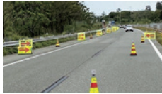
工事規制の様子
