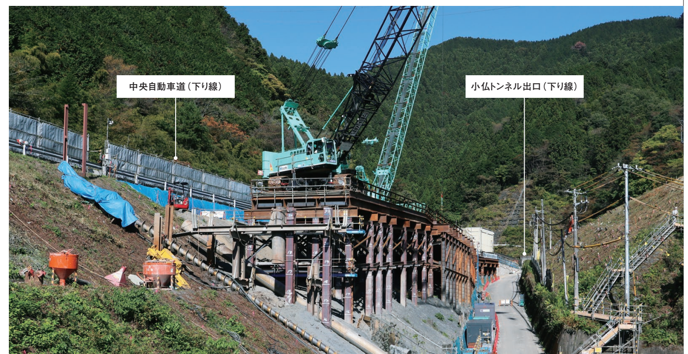
工事車両が出入りするための仮設道路の整備が、中央自動車道の下り線側で進んでいる。上り線側にトンネルを掘削するための重要なアクセスルートだ。(2020年11月5日撮影)
