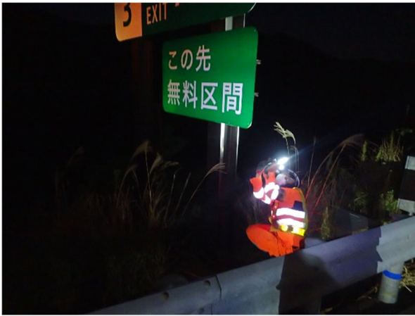
道路標識の点検状況
