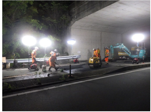
舗装の補修状況
