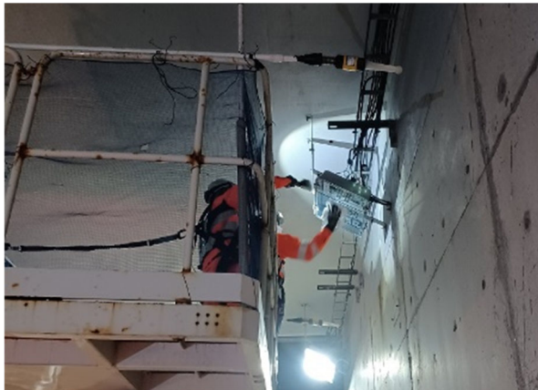
トンネル照明設備の灯具清掃状況
