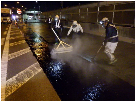
次に、高性能床版防水工を施工します
