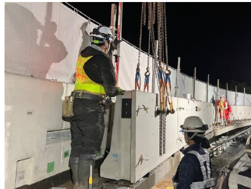
新しい壁高欄の設置状況
