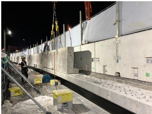
損傷した壁高欄の撤去状況
