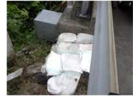
(土のうによる陥没の応急復旧)
