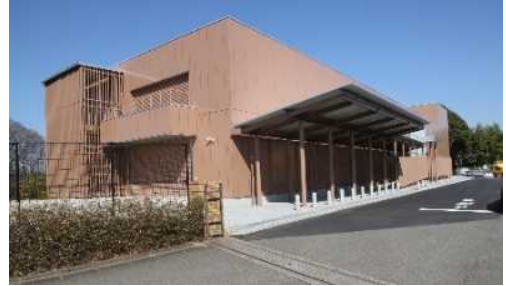
(八王子支社敷地内に整備した「安全啓発館」)
