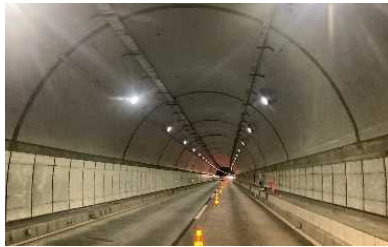
(トンネル覆工補強)
