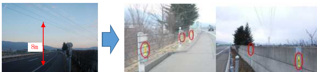
(高速道路上空の送電線)
