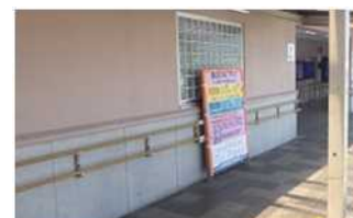
(手すりを塞いでいた看板)
