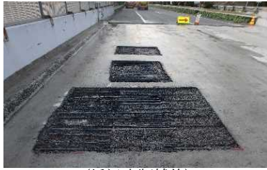
(橋梁床版補修)
