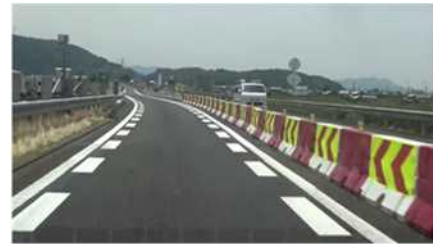
(対面通行区間の導流レーンマークと矢羽根シート)
