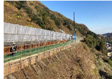
(中央道 小仏トンネル付近(上り線))
