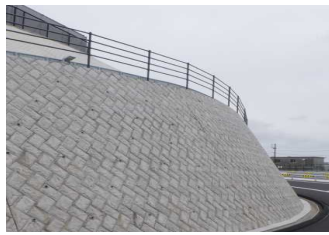
(ブロック積の上の転落防止柵)
