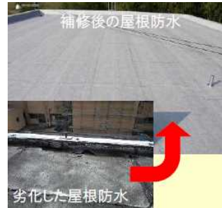
(建物延命化の一例：屋根防水の更新)
