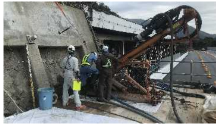
(グラウンドアンカー補強)
