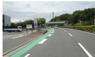
(入口部にカラー舗装を設置)
