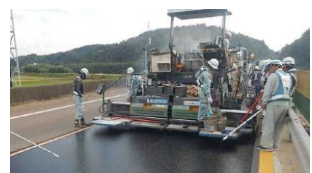
(開発したアスファルト混合物を供用路線で試験施工)
