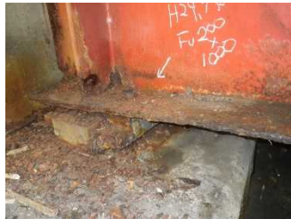
(判定区分Ⅲ：橋梁の桁端部の補修前)
