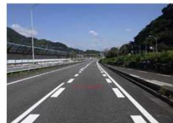
(導流レーンマーク+薄層舗装による対策後)
