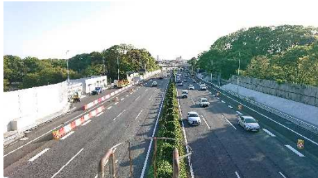
(東名高速道路 大和トンネル付近)
