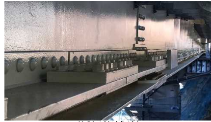
(橋梁桁補強)
