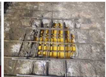
（変状箇所を除去した床版）
