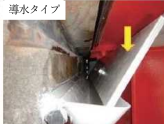
(桁端部劣化対策の各種試験施工)
