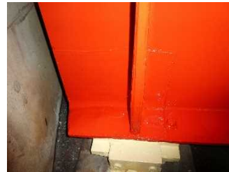
(判定区分Ⅲ：橋梁の桁端部の補修後)
