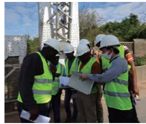
ザンビア国での橋梁維持管理に関する技術指導の状況
