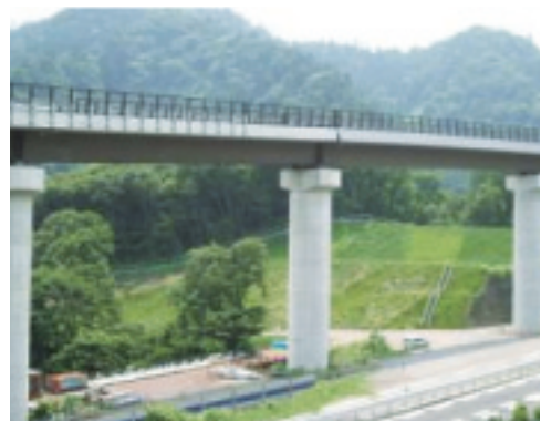
周辺色彩に配慮した柵
