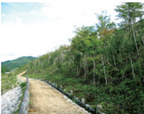
盛土のり面の樹林化
