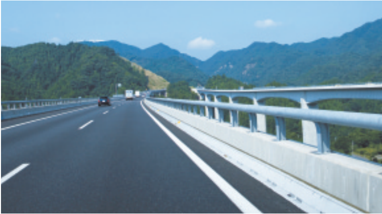
新名神 池山高架橋上からの車窓 (下り線)
