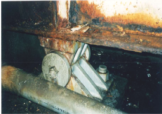
鋼桁の劣化
