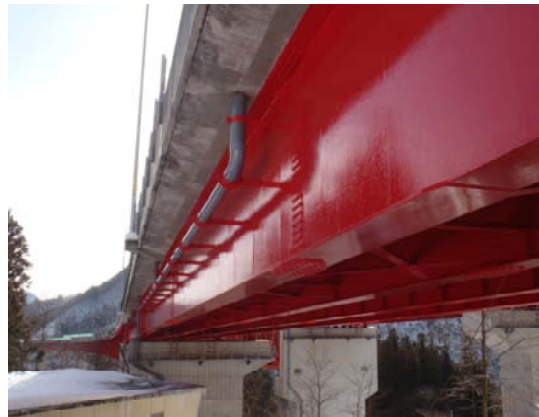
鋼桁の塗替塗装
