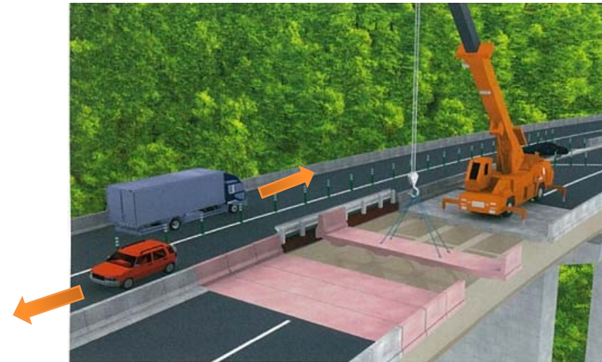
床版取替え工事のイメージ
