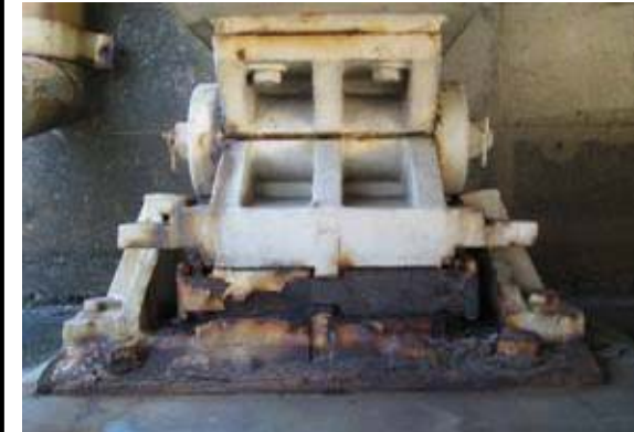
漏水による支承の劣化
