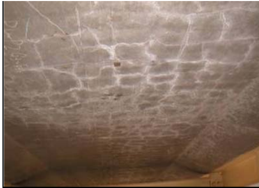
床版の疲労劣化
