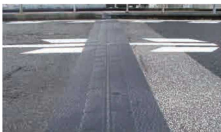
【伸縮装置の漏水対策】
