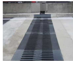
【鋼製大型伸縮装置の取替】
