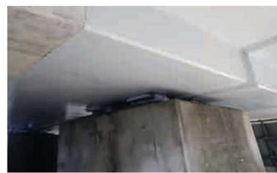
【桁端部のコンクリート表面保護】
