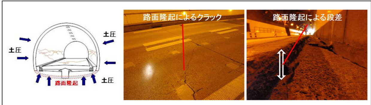
図－5 地盤材料の劣化によるトンネル内空の変状
