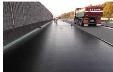
【グースアスファルトの施工】
