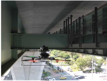
【無人航空機(UAV)を用いた橋梁の点検】
