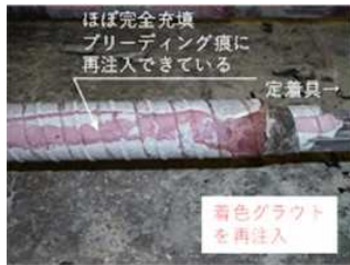
【PC鋼材のグラウト再注入】
