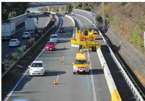
【移動式防護柵を用いた対面通行規制】
