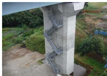
【高橋脚における昇降階段】
