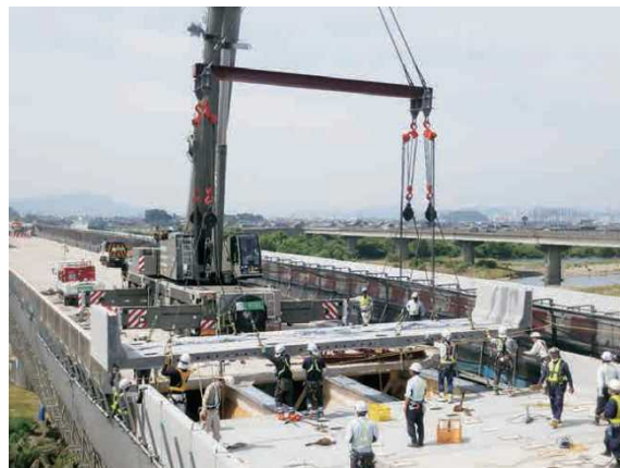
【プレキャスト部材を使用した床版取替工事】
