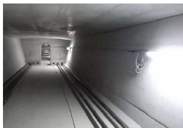
【橋梁箱桁内の点検用照明設備】
