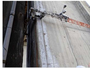
【壁昇降ロボットを用いた橋脚の点検】
