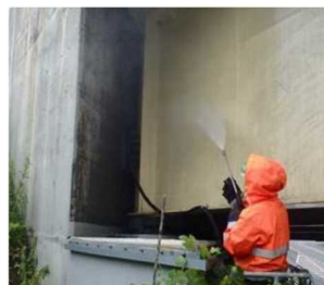
【桁端部の洗浄作業】
