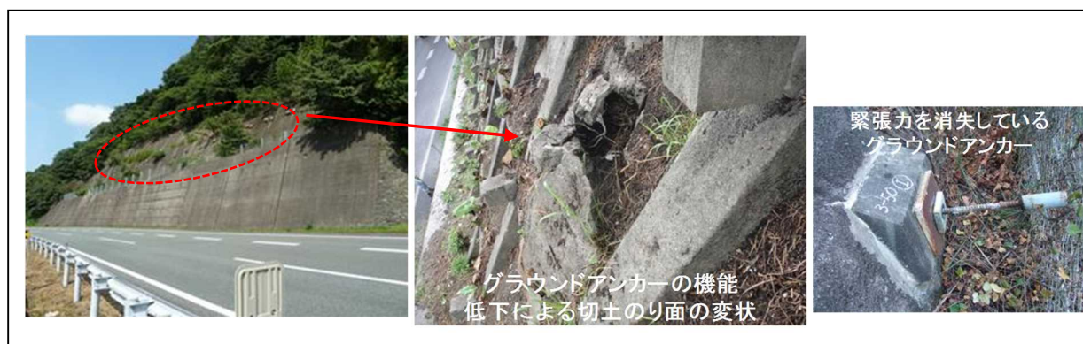
図-4 土構造物(グラウンドアンカー)の主な変状
