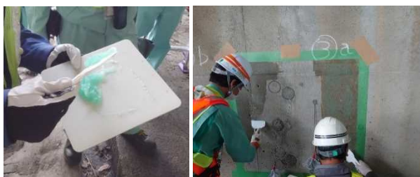
【亜硝酸リチウム入りゲル状材料の塗布】
