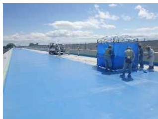
【高性能床版防水工】
