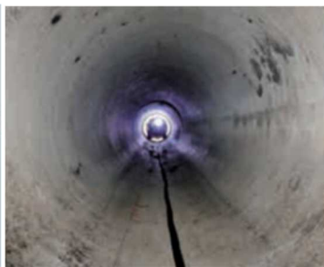
【ロボットを用いた管路内の点検】
