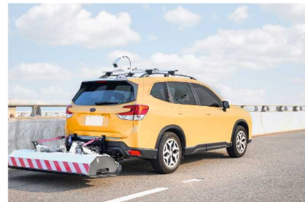
【床版内部の劣化状況調査】
