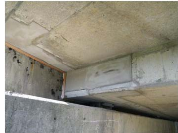
桁端部の断面修復
