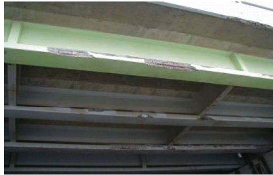
塩分による桁の劣化
