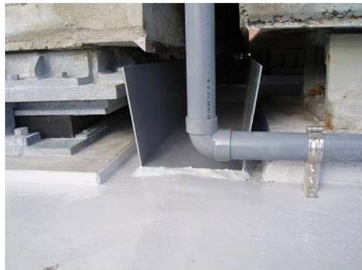
桁端部漏水対策
