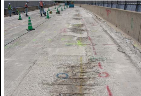
床版上面の劣化
