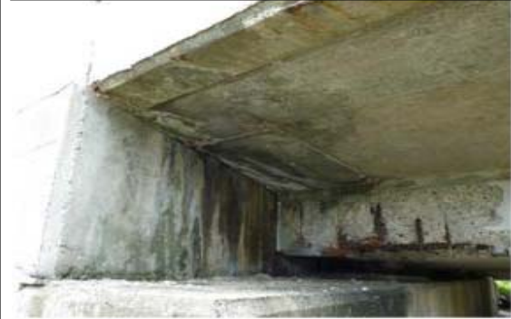
漏水による桁端部の劣化
