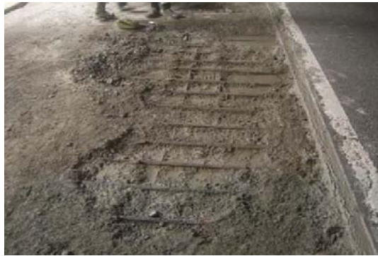
床版上面の劣化
