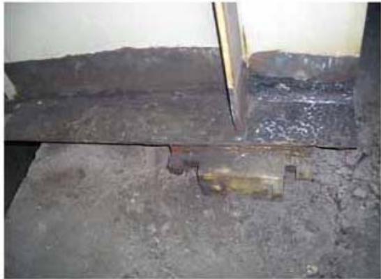
漏水による桁端部の劣化
