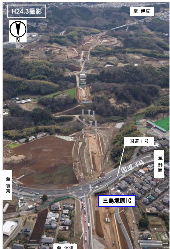
三島塚原ICから平成25年度開通予定区間を望む
