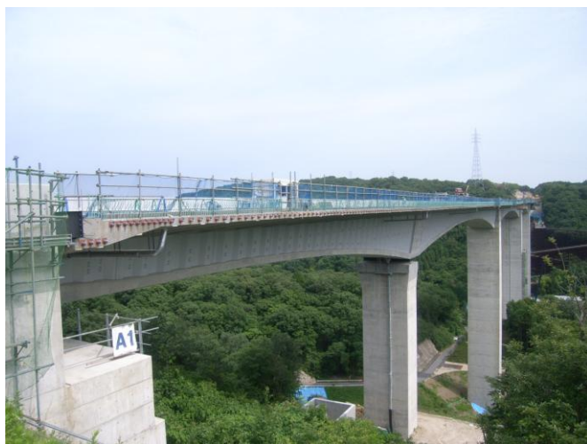
写真1 青木川橋（仮称） 全景（手前は豊田市側）
