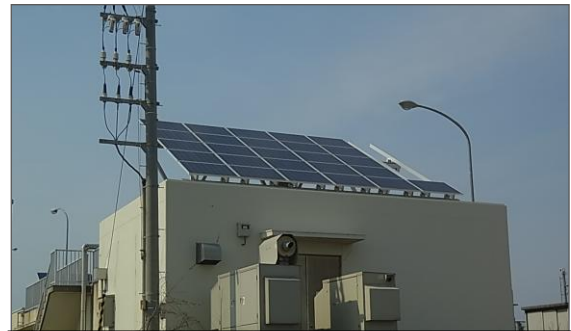
徳光PA上り線 太陽光発電設備 3箇所、計8.4kW
