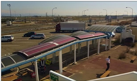
徳光PA下り線 太陽光発電設備 2箇所、計1.8kW
