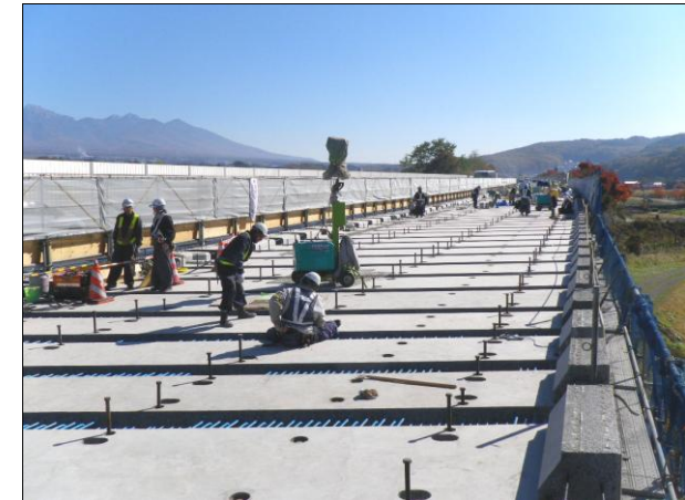
床版新設状況の例
