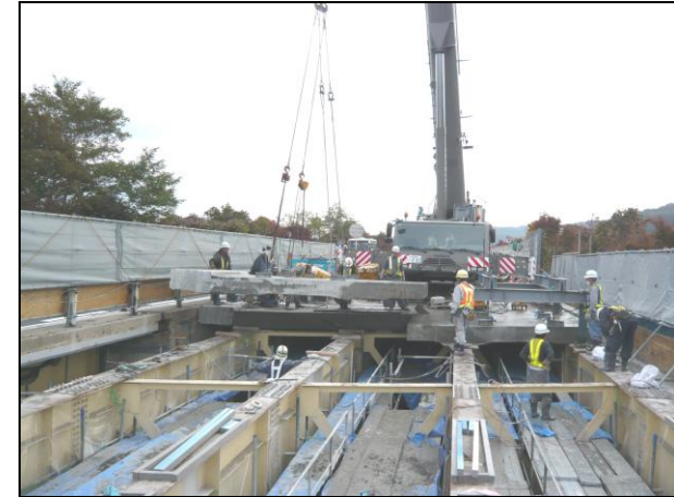
床版撤去状況の例
