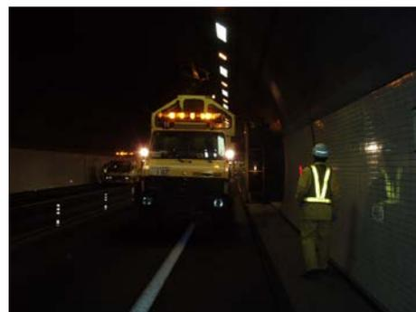
消えかかっている路面標示の引き直し、破損した車線分離標を取り替えます。
