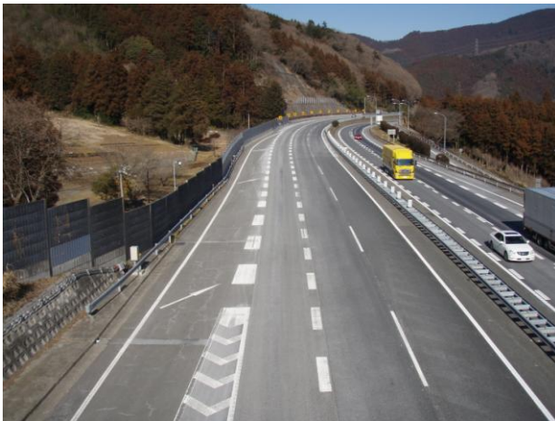
② 小仏トンネル手前「2車線+登坂車線」～2月末撮影～ ※一番左側のレーンは、バスストップの合流レーン
