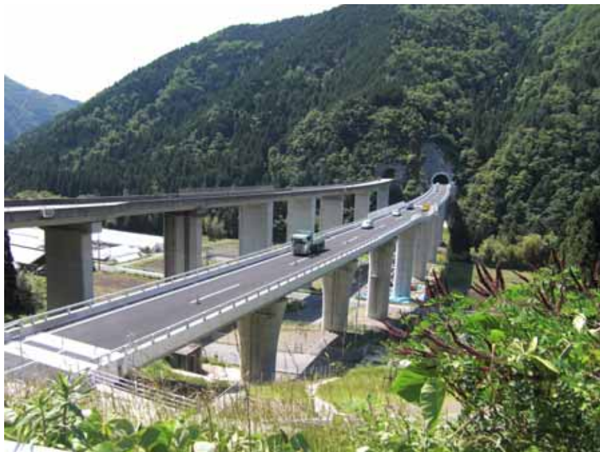
寺本トンネル南坑口上から西乙原トンネル北坑口を望む(亀尾島川橋走行車線規制)
