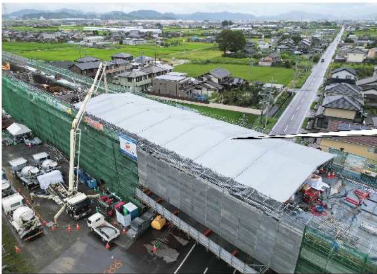
雨よけ(テント)設置によって天候に影響を受けないコンクリートの打設(近接高架橋での実施例)
