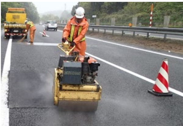
《路面損傷箇所の補修》
