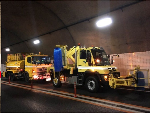
《トンネル側壁清掃》
