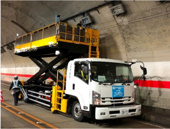
《設備清掃・点検》
