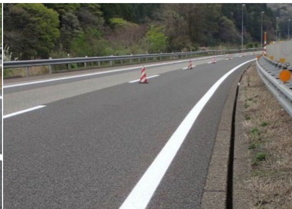
《路面標示の施工》
