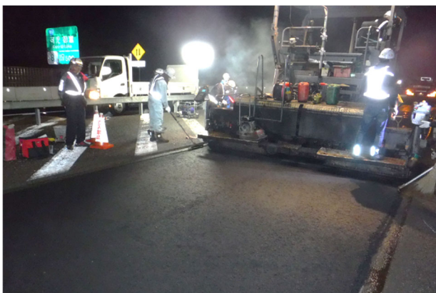
舗装の補修状況
