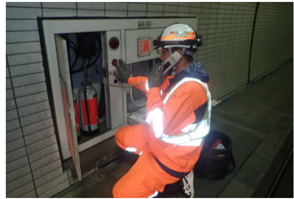
トンネル非常用設備の点検状況
