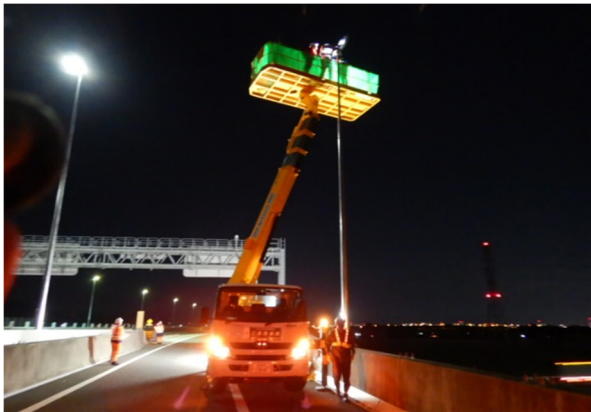
道路照明設備の点検状況
