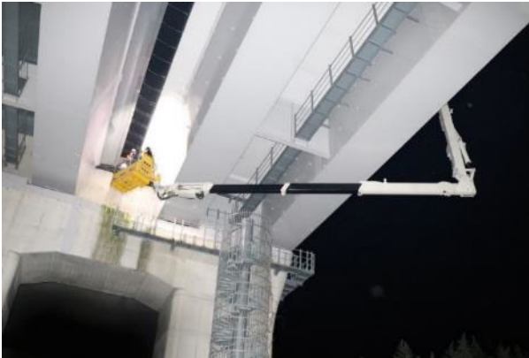
橋梁の点検状況
