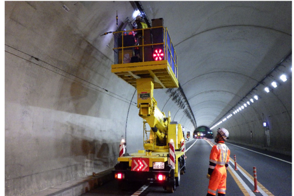
トンネル照明設備の清掃状況
