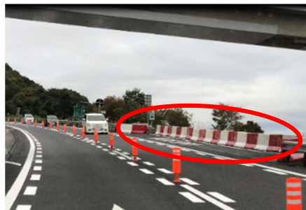
非常駐車帯の設置
