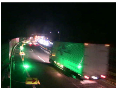
LED ライトによる視線誘導
