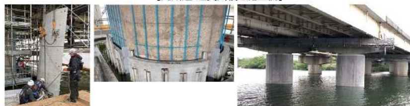
【九州道 遠賀川橋の施工例】
