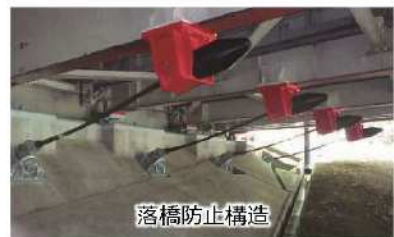
設計地震力から約90パターン標準図を作成
