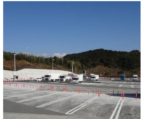
写真1 大型駐車マスの完成状況
