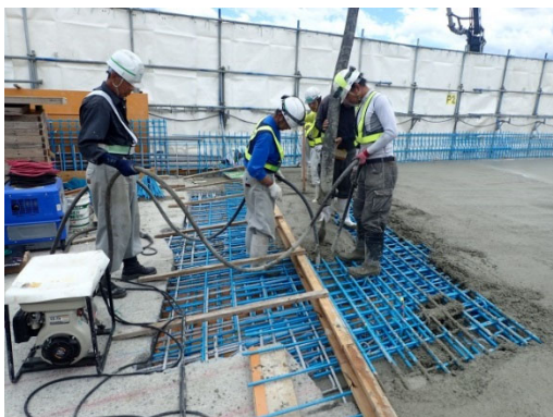
現場打ち床版の施工状況
