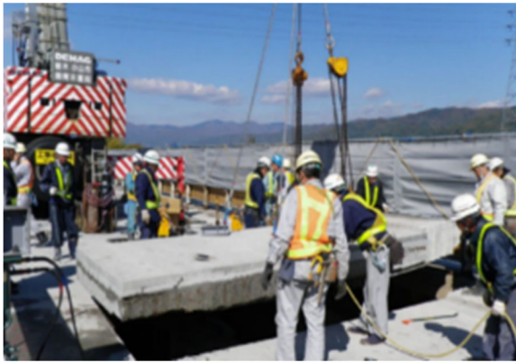
老朽化した床版の撤去
