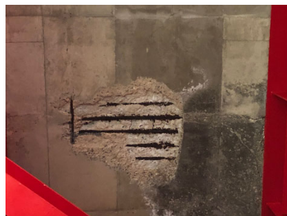
落合川橋の床版下面
