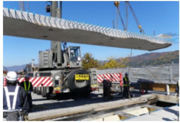
新しい床版の設置
