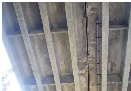
上田川橋の床版下面
