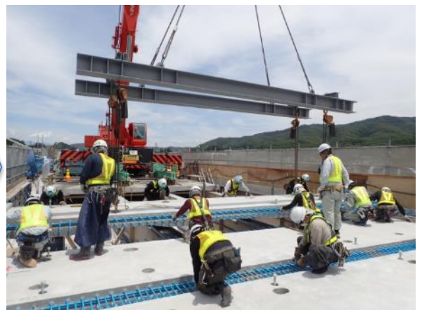
(プレキャスト床版の施工状況)
