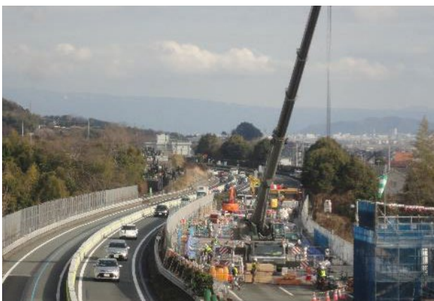
(床版取替工事 全景)
