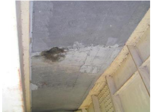
(床版の損傷状況 (床版下面に漏水が発生))
