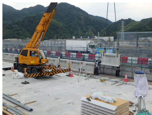
(プレキャスト壁高欄の施工状況)
