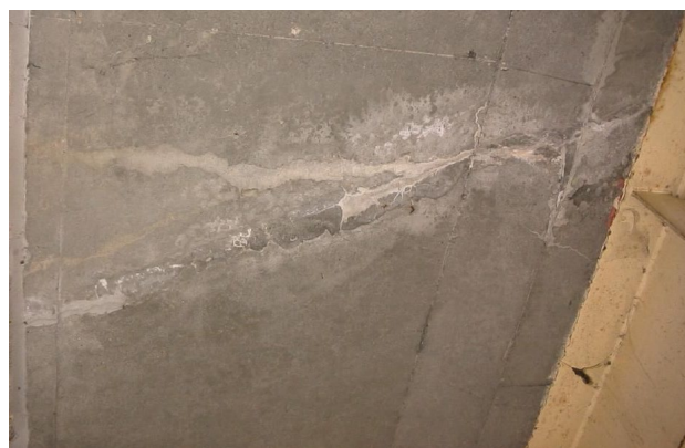
(床版の損傷状況 (床版下面に遊離石灰が発生))
