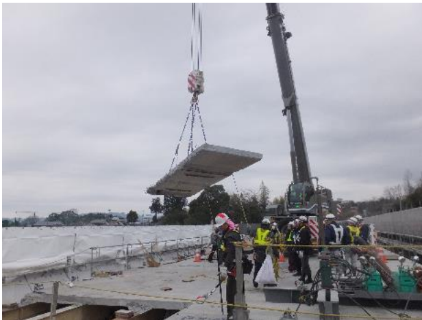
(老朽化した床版の撤去)
