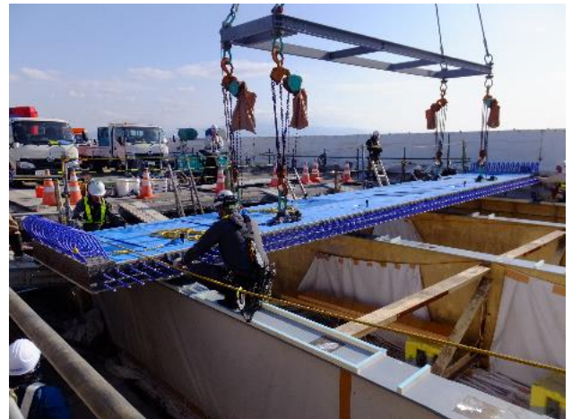
(新しい床版の設置)
