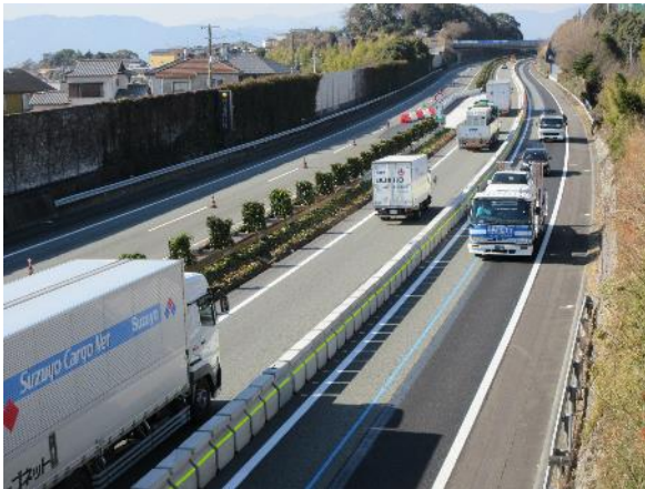
(2017 年度冬 東名リニューアル工事 コンクリート防護柵設置状況)
