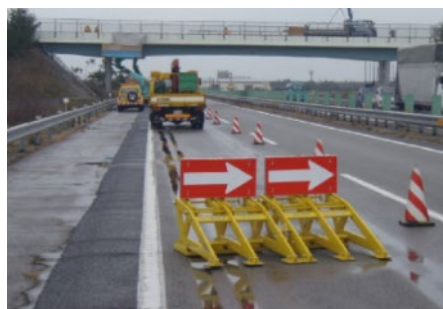
(物理的防御装置設置状況)
