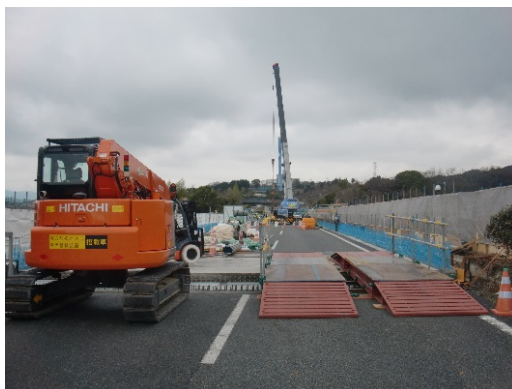
(仮橋設置状況 (伸縮装置部))
