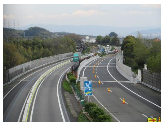
(床版取替完了後)
