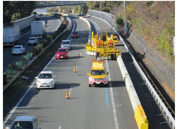
(2017 年度冬 東名リニューアル工事 コンクリート防護柵設置状況)
