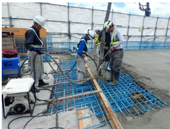
(現場打ち床版の施工状況)
