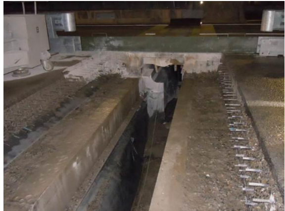
②伸縮装置の撤去後の状況
