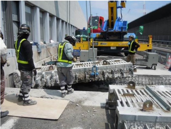
① 損傷した伸縮装置を撤去
