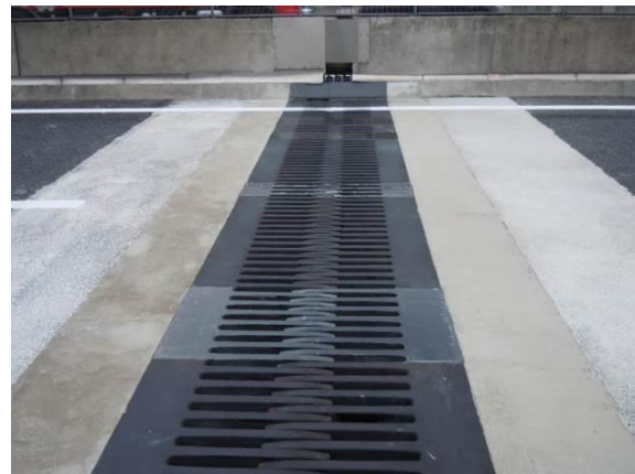
④工事完了
