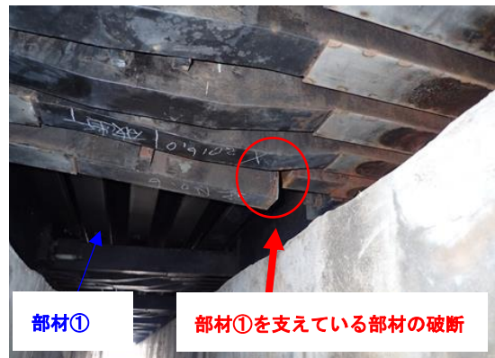
橋梁下面からの伸縮装置損傷状況
