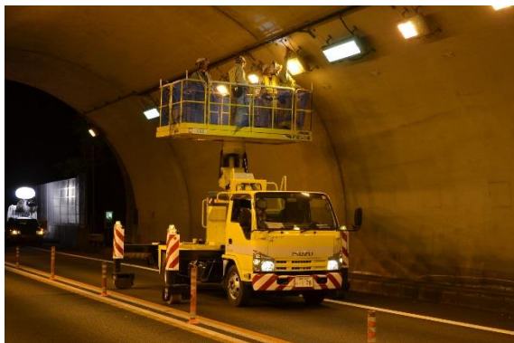
(トンネル照明点検)
