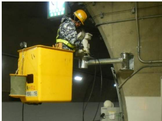
(CCTV カメラの設置)
