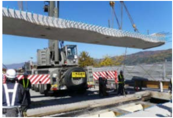
新しい床版の設置
