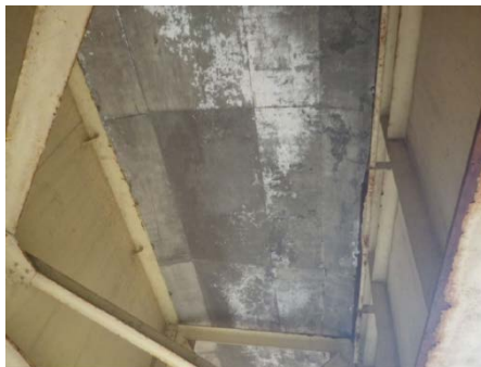
山中橋の床版下面
