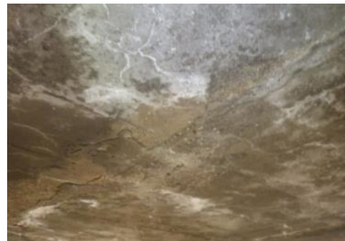
沓掛橋の床版下面
