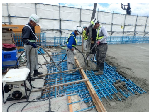
現場打ち床版の施工状況
