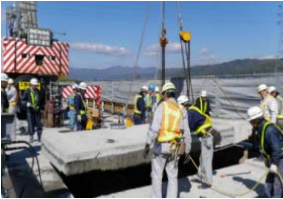
老朽化した床版の撤去
