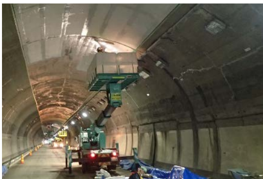
繊維シートの貼付け工事実施状況例
