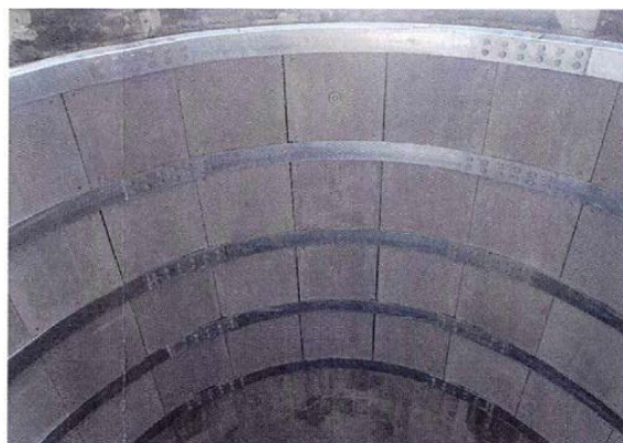
コンクリート版と鋼材による補強工事完了例
