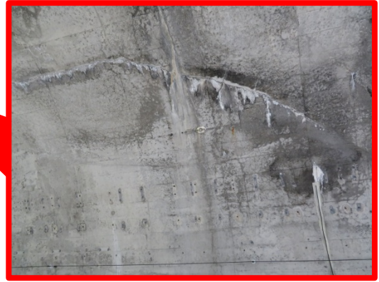
トンネル覆工コンクリートのひび割れ状況
