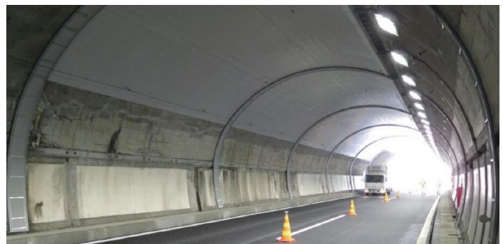
繊維シートの貼付け工事完了例
