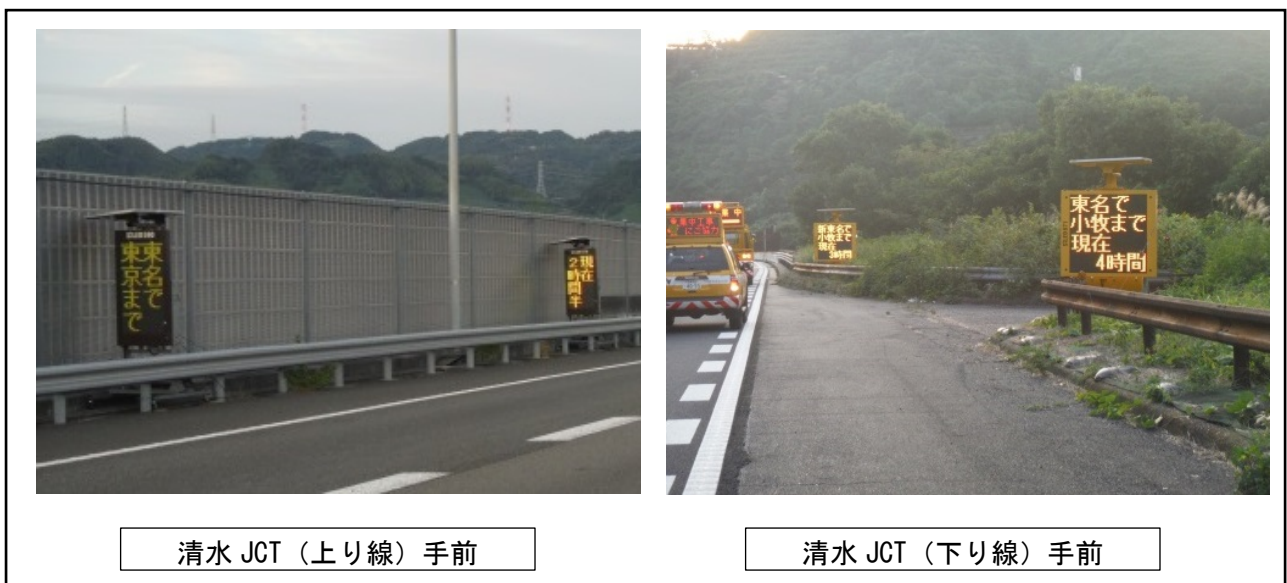
【迂回ルートへの分岐部手前の仮設 LED 情報板の所要時間表示イメージ（昨年度設置状況）】
